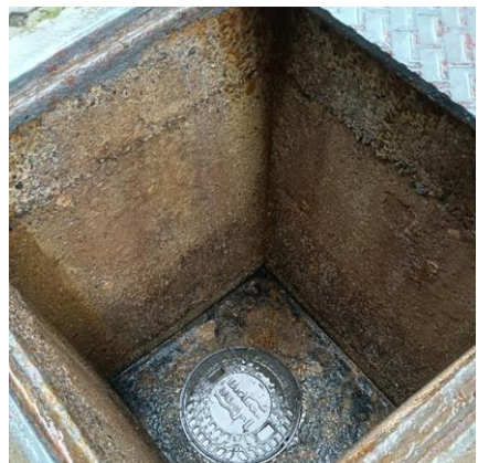
รูปที่ 3.1-11 ขุดลอกตะกอน และทำความสะอาดบ่อพักน้ำทิ้ง ล่าสุดเมื่อเดือนกรกฎาคม 2566
