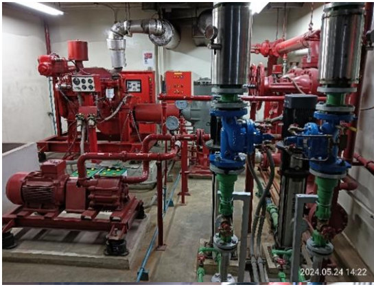
รูปที่ 3.1-18 ระบบสูบน้ำสำหรับดับเพลิง
