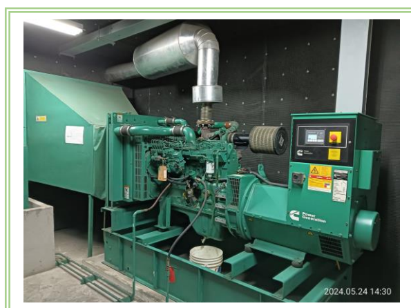
รูปที่ 2.5-10 เครื่องกำเนิดไฟฟ้า (Generator)
