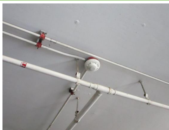
รูปที่ 2.5-11 ระบบสัญญาณเตือนอัคคีภัยภายในอาคาร
